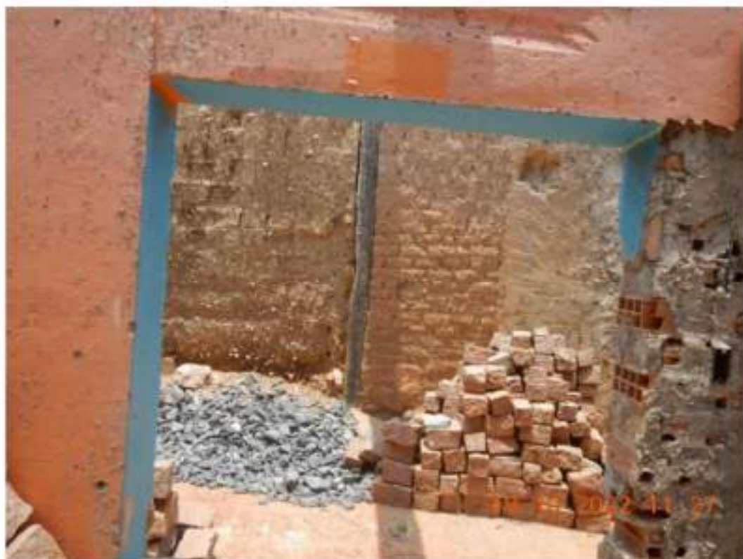
Figura 37 – Vista do interior da edificação localizada na Rua Engenheiro Ricardo Franco, “Nº600”.
