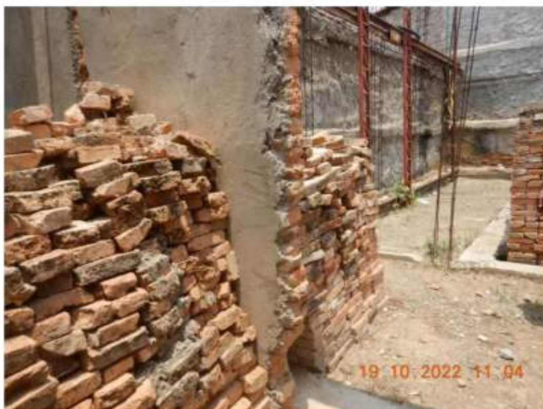
Figura 22 – Vista do interior da edificação localizada na Rua Engenheiro Ricardo Franco, “Nº473”.
