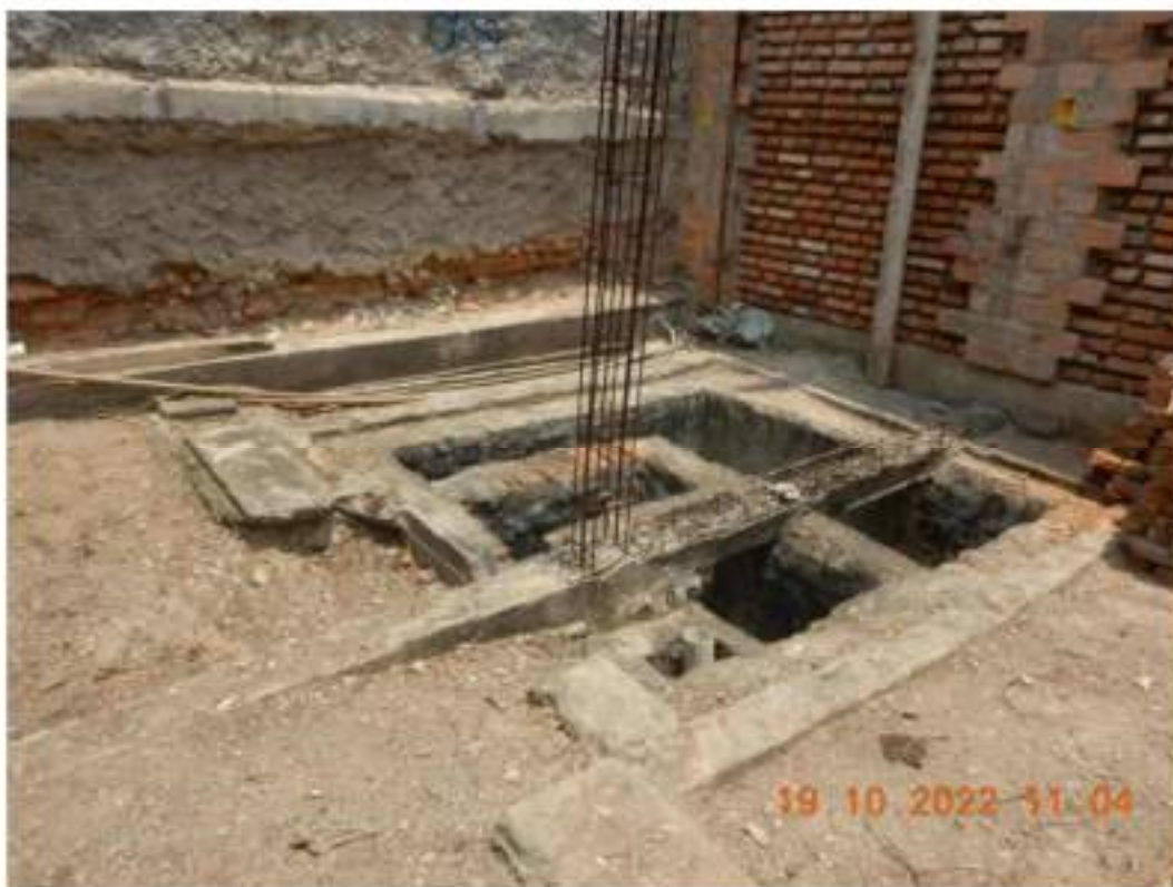
Figura 23 – Vista dos fundos da edificação localizada na Rua Engenheiro Ricardo Franco, "Nº473". Observar escavação na área externa para construção de sistema sanitário.
