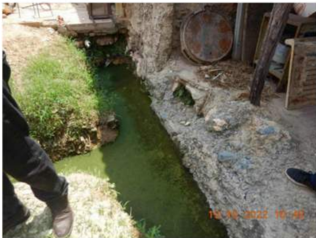
Figura 10 – Vista da cava aberta para escoamento de chuva pluvial da área externa da edificação localizada na Rua Engenheiro Ricardo Franco, “Nº459”.
