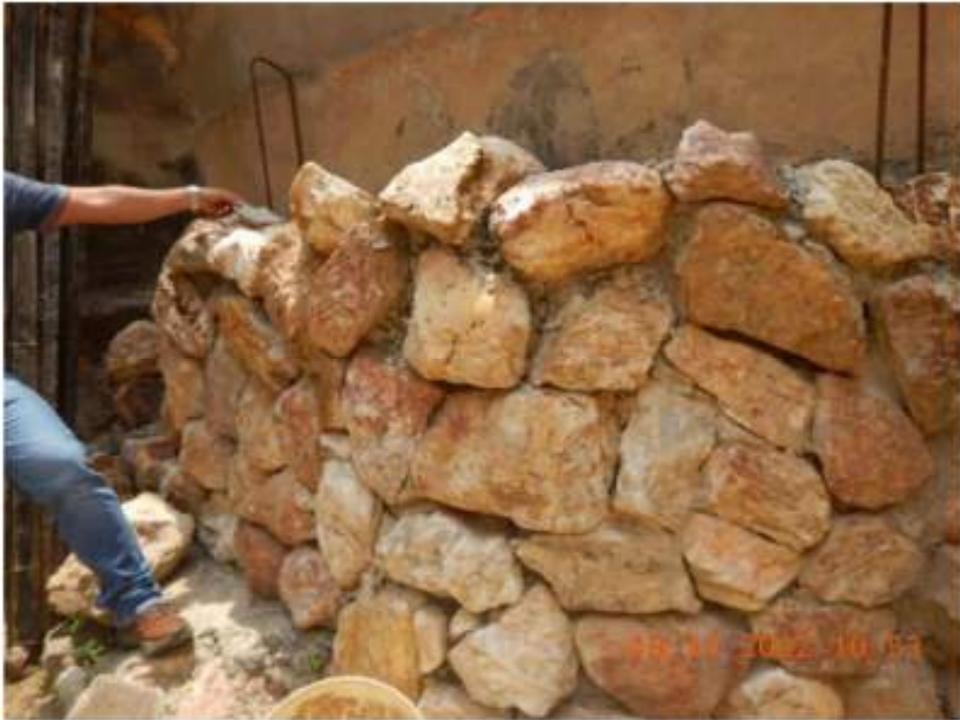
Figura 13 – Vista de muro de arrimo construído para evitar desmoronamento da parede que fica nos fundos da edificação localizada na Rua Engenheiro Ricardo Franco, “Nº461”.
