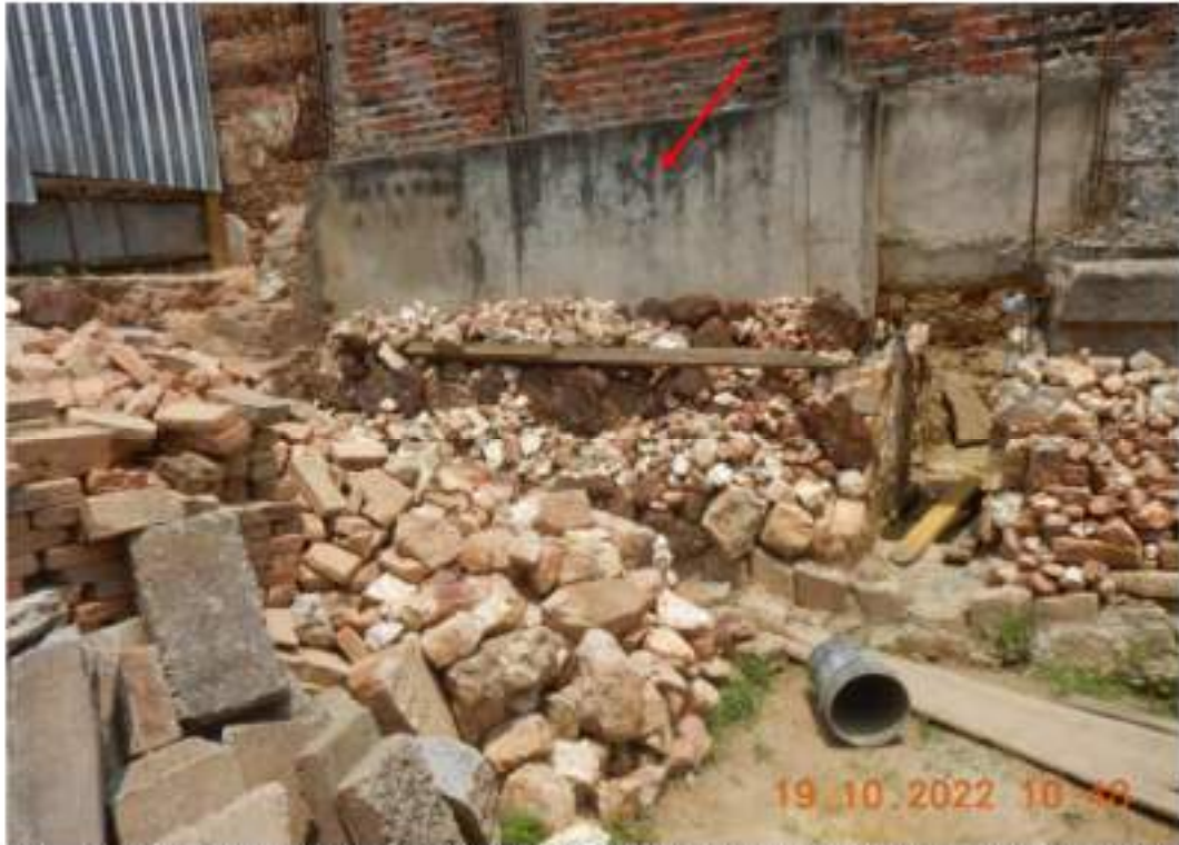
Figura 9 – Vista de muro de arrimo (seta vermelha) construído para evitar desmoronamento da parede que fica nos fundos da edificação localizada na Rua Engenheiro Ricardo Franco, “Nº459”.
