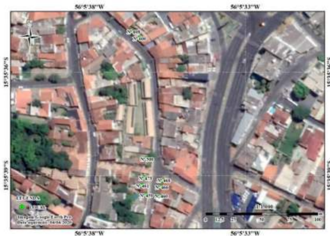
Figura 43 – Imagem do aplicativo Google Earth Pro de 04 de abril de 2020, onde se constatou que nos terrenos dos imóveis questionados “N°600” e “N°608” havia sinais de escavação/alteração.
