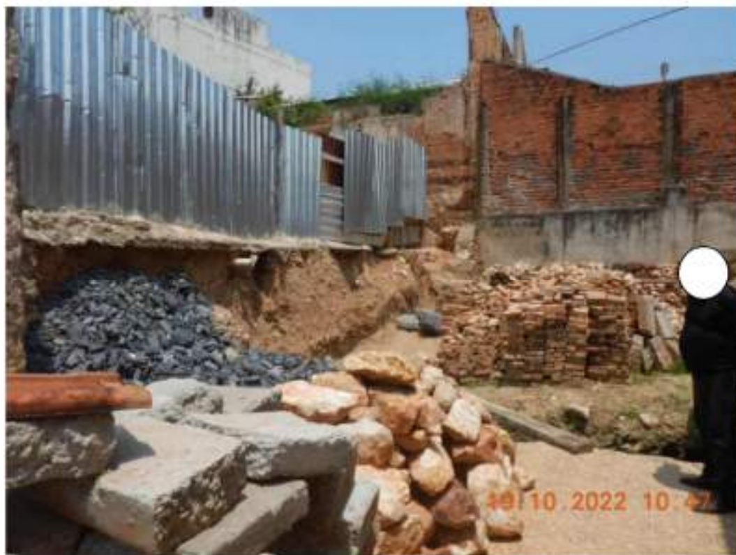
Figura 7 – Vista da área externa da edificação localizada na Rua Engenheiro Ricardo Franco, “Nº459”.
