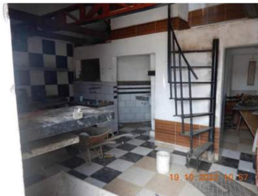
Figura 20 – Vista do interior da edificação localizada na Rua Engenheiro Ricardo Franco, “Nº468”.
