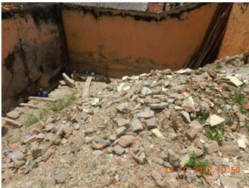
Figura 11 – Vista dos entulhos provenientes da escavação do aterro para construção das valas para drenagem das águas pluviais da edificação localizada na Rua Engenheiro Ricardo Franco, “Nº461”.
