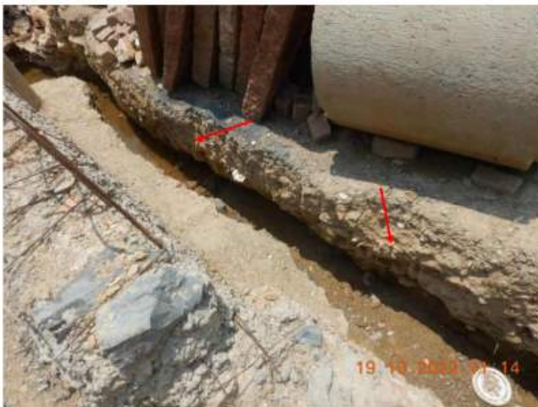
Figura 31 – Vista das valas para drenagem das águas pluviais, abertas no interior da edificação da Rua Engenheiro Ricardo Franco, “Nº500”. Observar que a escavação atingiu apenas o aterro (seta vermelha), não chegando nas rochas do Grupo Cuiabá.
