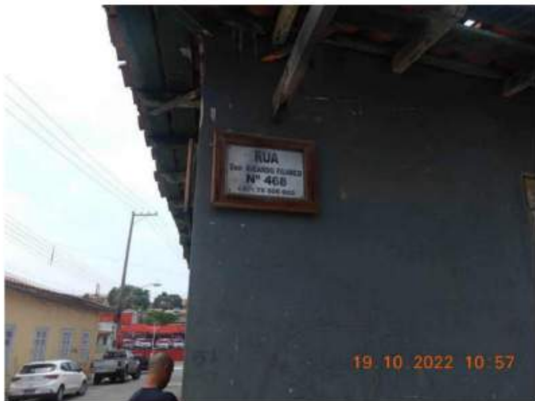
Figura 19 – Vista da entrada da edificação localizada na Rua Engenheiro Ricardo Franco, “Nº468”.
