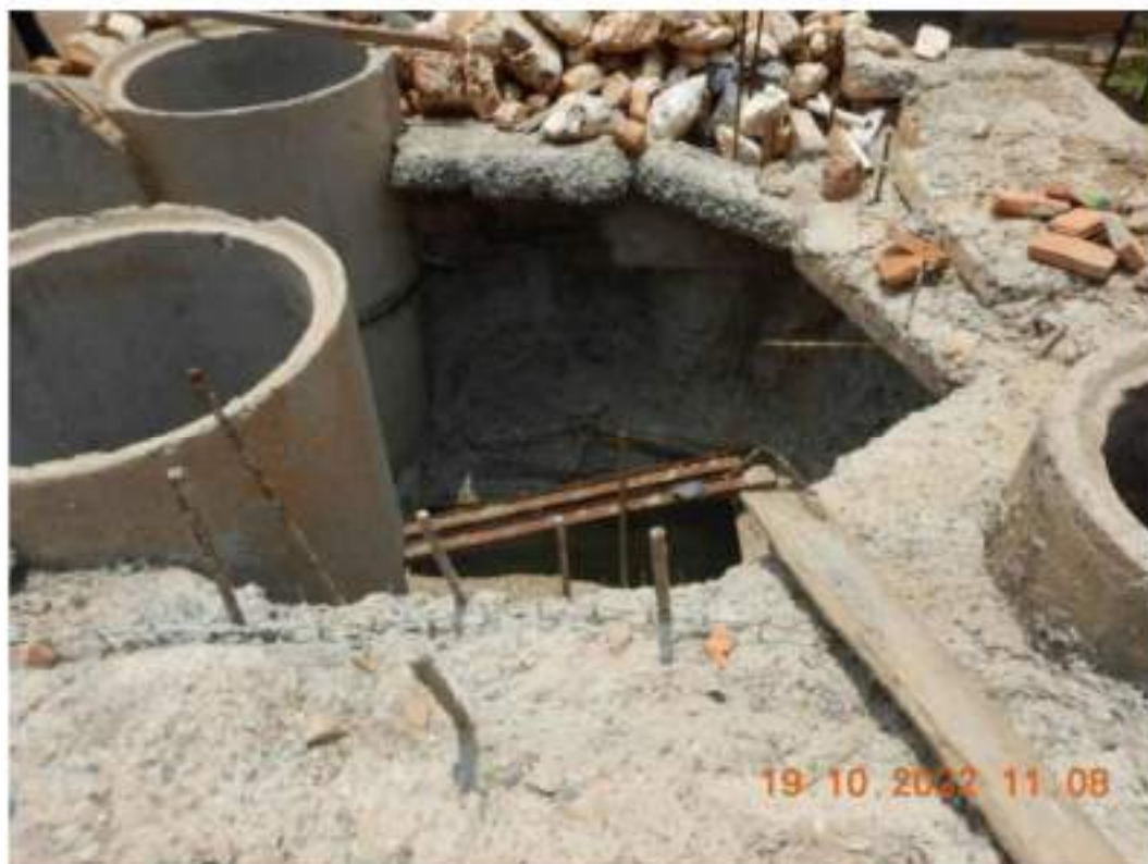
Figura 27 – Vista da caixa de águas pluviais construída no interior da edificação localizada na Rua Engenheiro Ricardo Franco, “Nº500”.
