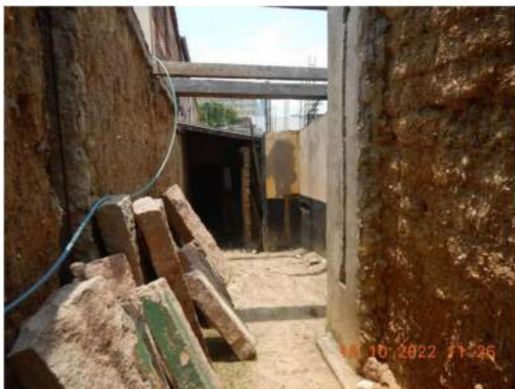
Figura 34 – Vista do interior da edificação localizada na Rua Engenheiro Ricardo Franco, “Nº608”.
