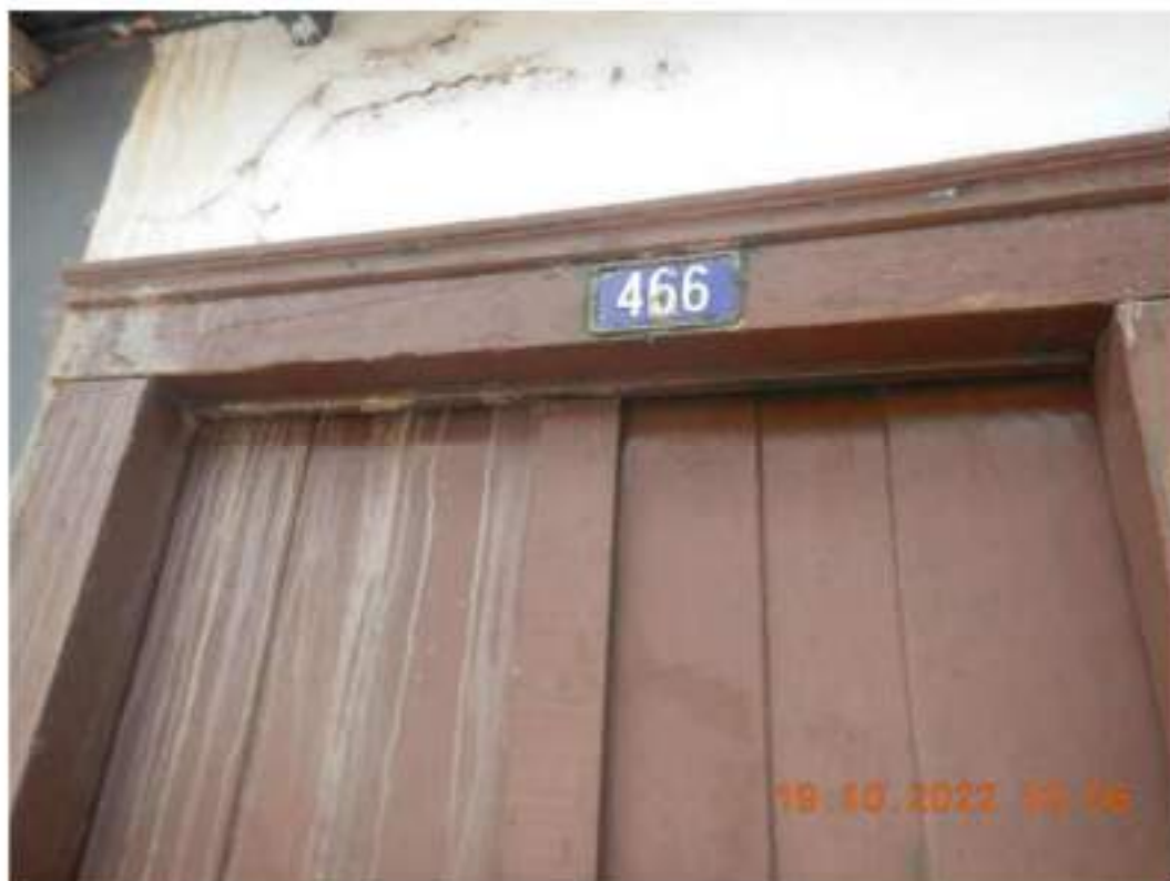
Figura 17 – Vista da entrada da edificação localizada na Rua Engenheiro Ricardo Franco, “Nº466”.
