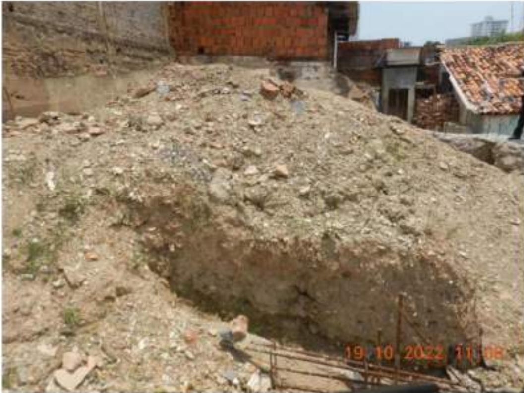
Figura 29 – Entulhos provenientes da escavação do aterro para construção das valas para drenagem das águas pluviais, depositados no interior do imóvel da Rua Engenheiro Ricardo Franco, “Nº500”.
