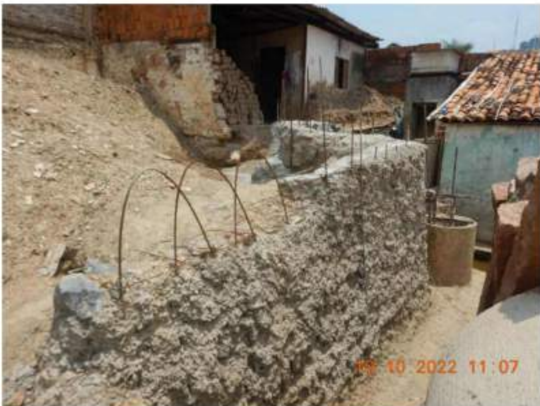
Figura 26 – Vista do interior da edificação localizada na Rua Engenheiro Ricardo Franco, "Nº500". Observar construção de muro de arrimo.
