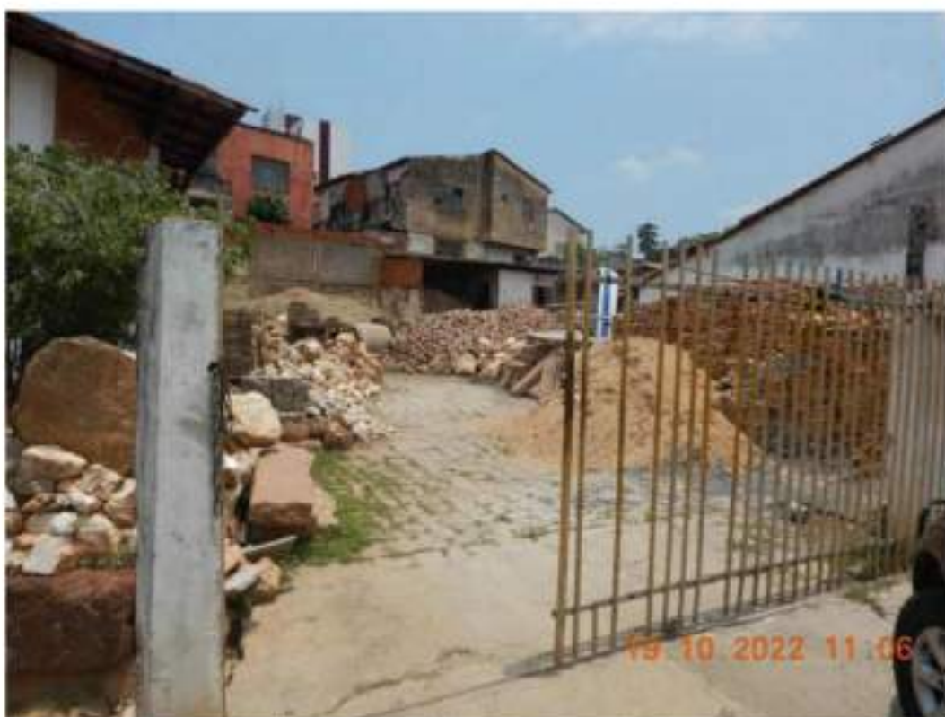
Figura 24 – Vista da geral da edificação localizada na Rua Engenheiro Ricardo Franco, "Nº500".
