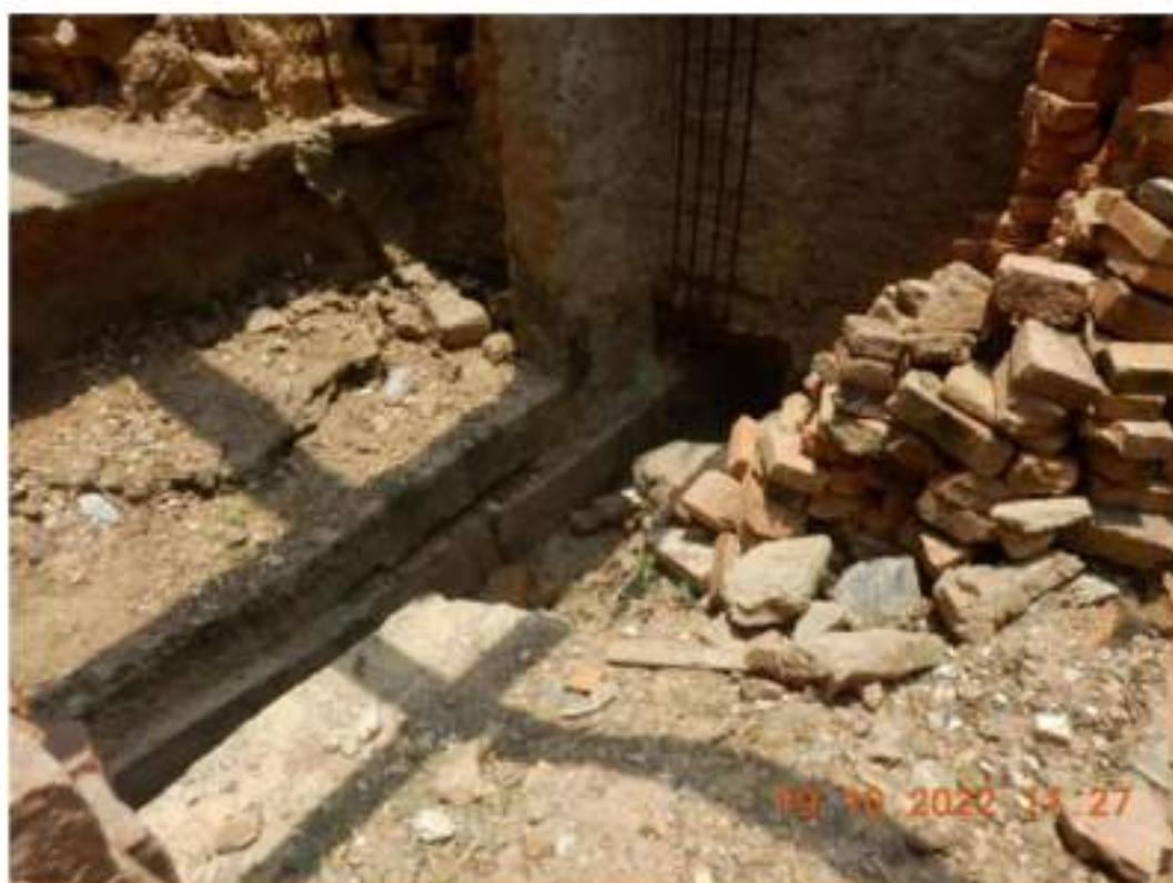
Figura 38 – Vista do interior da edificação localizada na Rua Engenheiro Ricardo Franco, “Nº600”.
