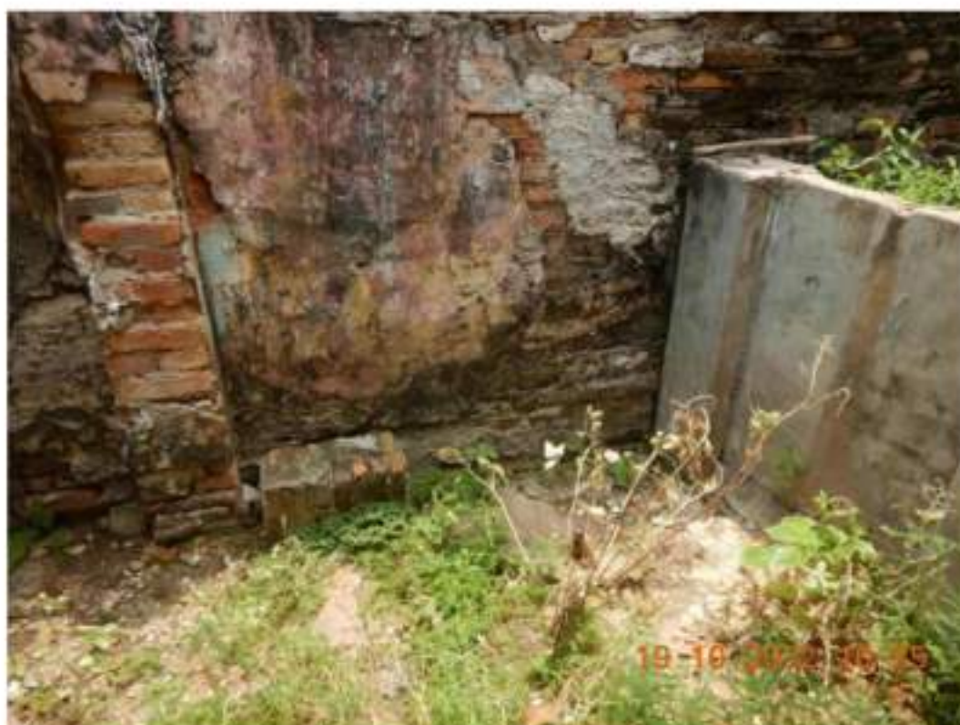
Figura 16 – Vista dos fundos da edificação localizada na Rua Engenheiro Ricardo Franco, "Nº460".
